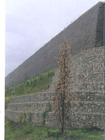
Durch Anordnung einer Ortbetonscheibe in einer frei stehenden und flach gegründeten Gabionenwand werden **Quicky Forte**, **Quicky Forte S** oder **Quicky Light** zum einzigartigen Lärmschutzwandsystem **LSW 2000**. Durch Lavagestein auf der der Schallquelle zugewandten Fläche wird die optimale natürliche Absorption des Gesteins mit einer ästhetischen Optik kombiniert. Der Ortbetonekern sorgt für eine fugenlose Schallbarriere in der Konstruktion und dient gleichzeitig als Aussteifungselement.
